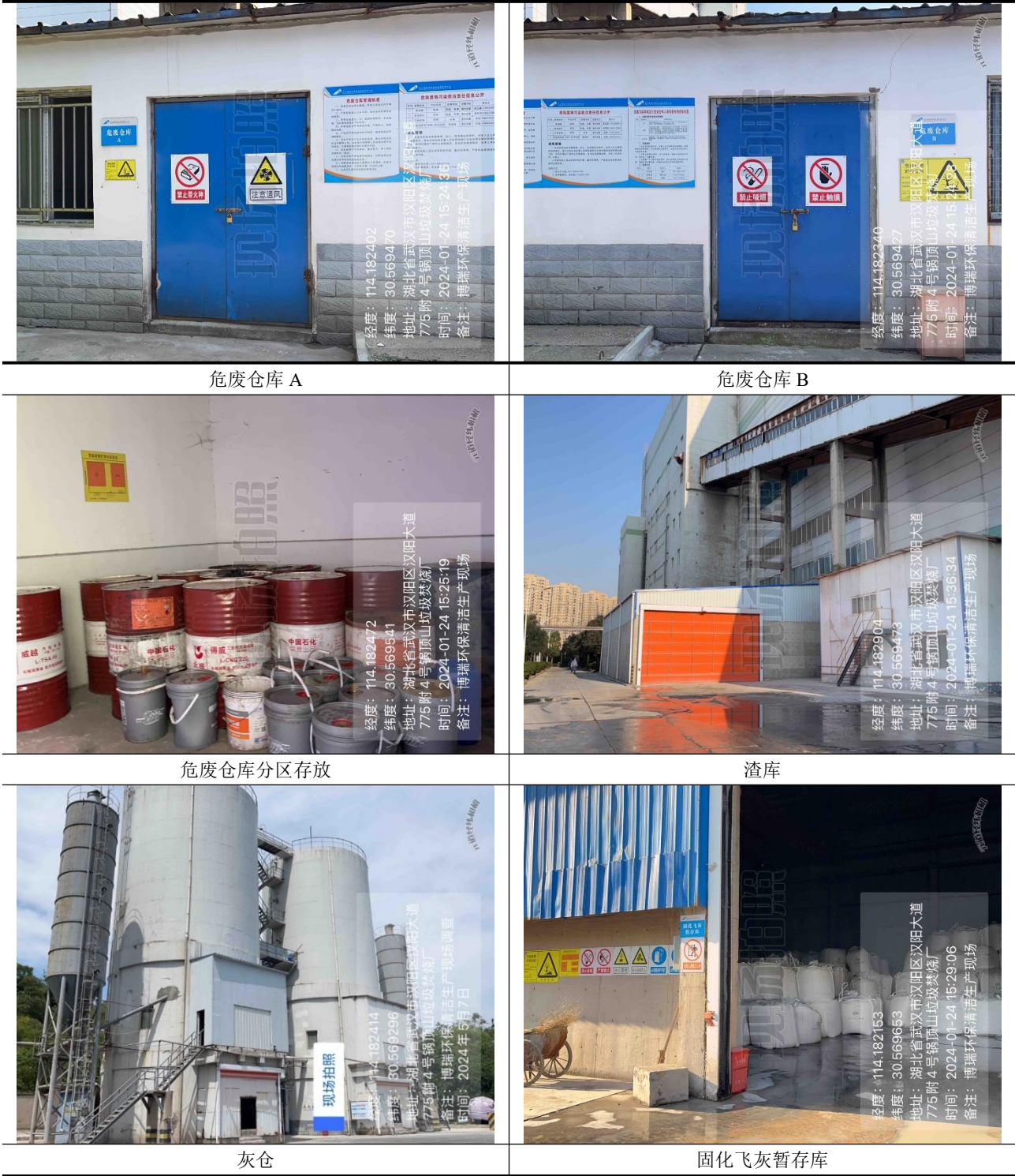
图 3.2-4 固废暂存系统现场实景图
