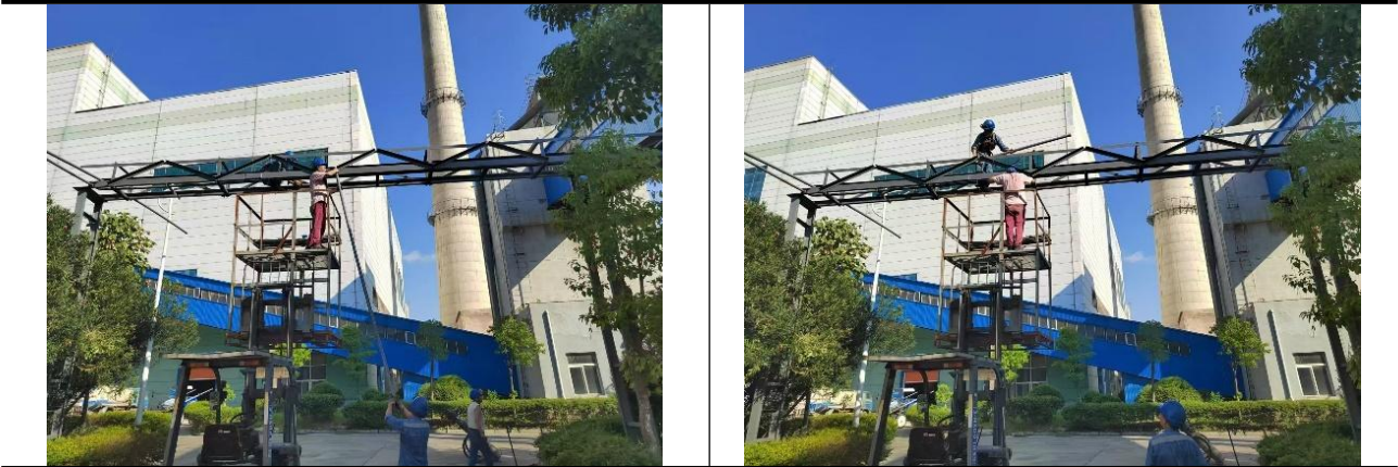
F7 渗滤液站超滤膜清洗水管改造
